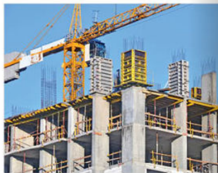
Figura 1.42 El proceso de fraguado tarda algunos días. La mezcla ha de mantenerse en la forma final mientras endurece o mientras está fraguando.
