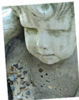
Figura 4.38 Efectos de la lluvia ácida en la piedra.
