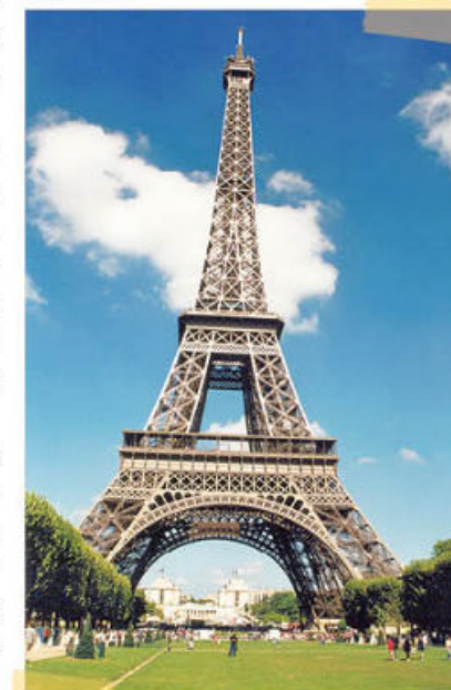
Figura 4.50 La Torre Eiffel recibe una capa de pintura cada siete años para protegerla de la corrosión.
